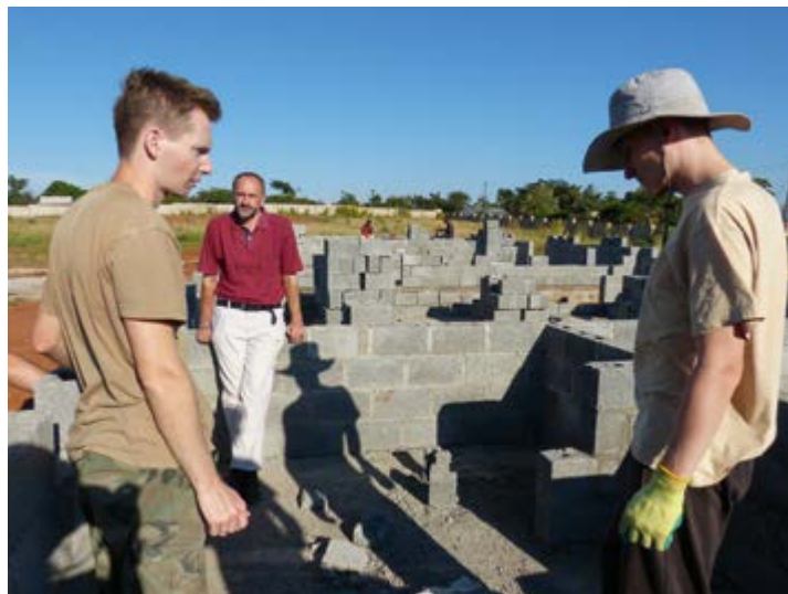
Z wolontariuszami na budowie przedszkola
